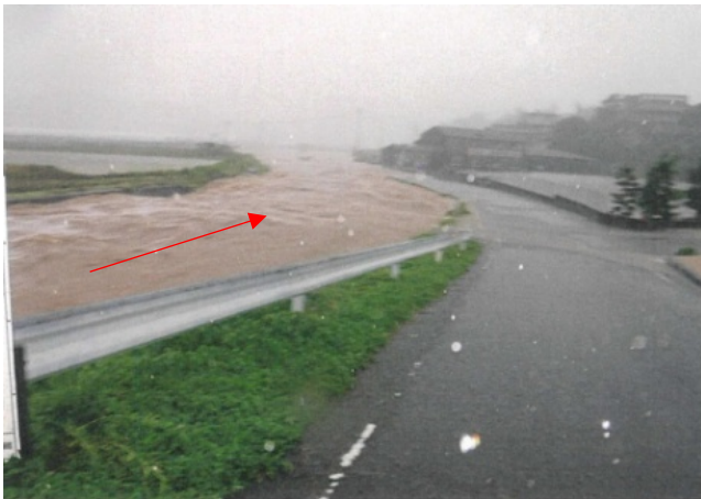
設置位置付近の洪水状況（長崎県提供）
