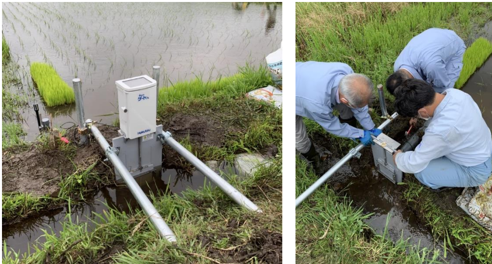
図 6-10：A-01 圃場の水まわりゲートくんと設置作業
