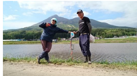
図 14-47 : 水田センサーKS-03 設置状況
