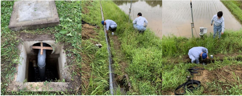
図-1 段差のある地形を利用してエアダスバルブ（水まわりくん）を設置
