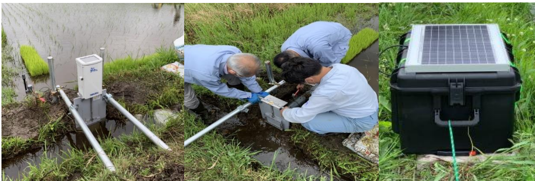
図-2 土溝の水口のため、土を掘り返し、給水ゲート（水まわりゲートくん）を設置。
